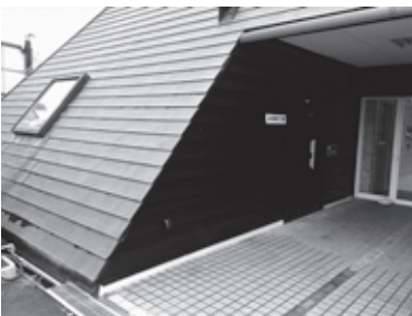
JN 築炉工事 瑞浪市山田町533
